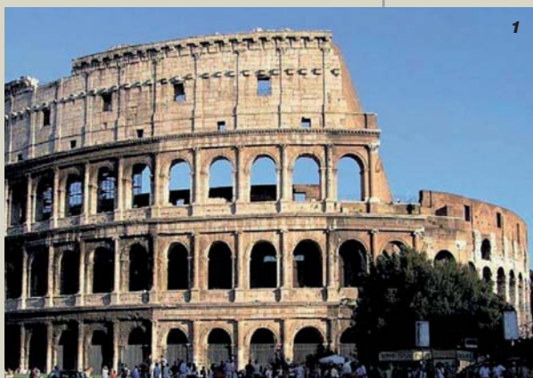
1. L'incredibile durabilità dei conglomerati cementizi dell'antica Roma deriva dall'uso della pozzolana presente in grandi quantità nella regione laziale
