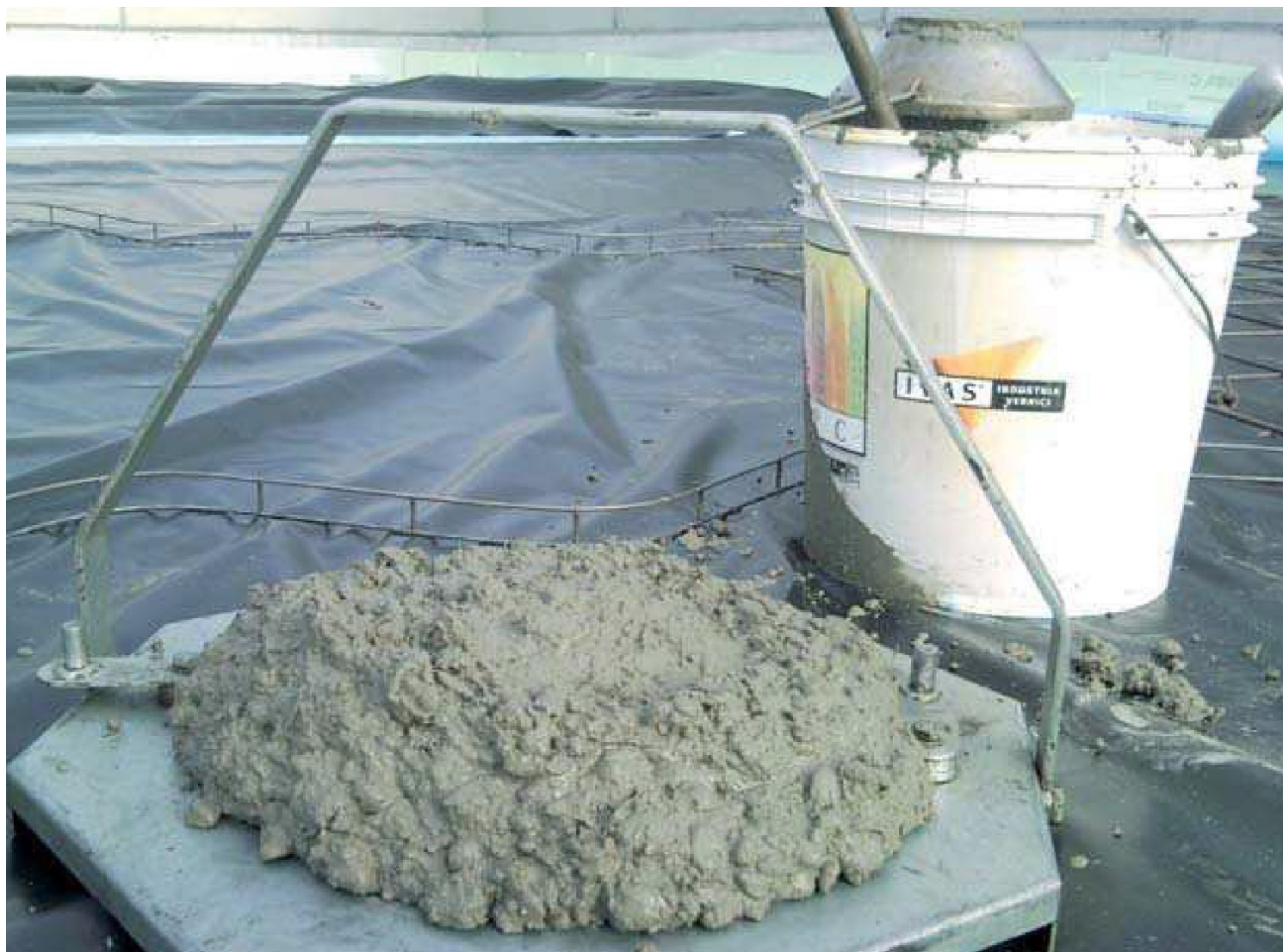
Il cantiere di Mestre (VE)
