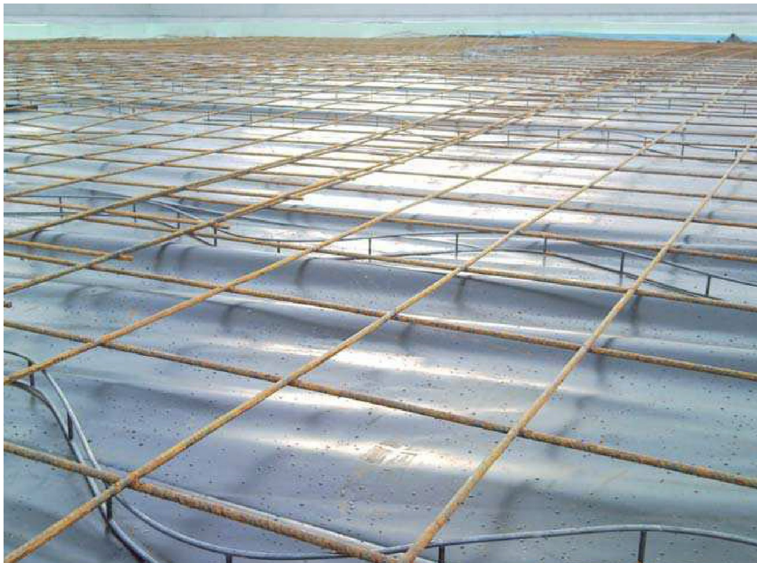
Il cantiere di Mestre (VE)
