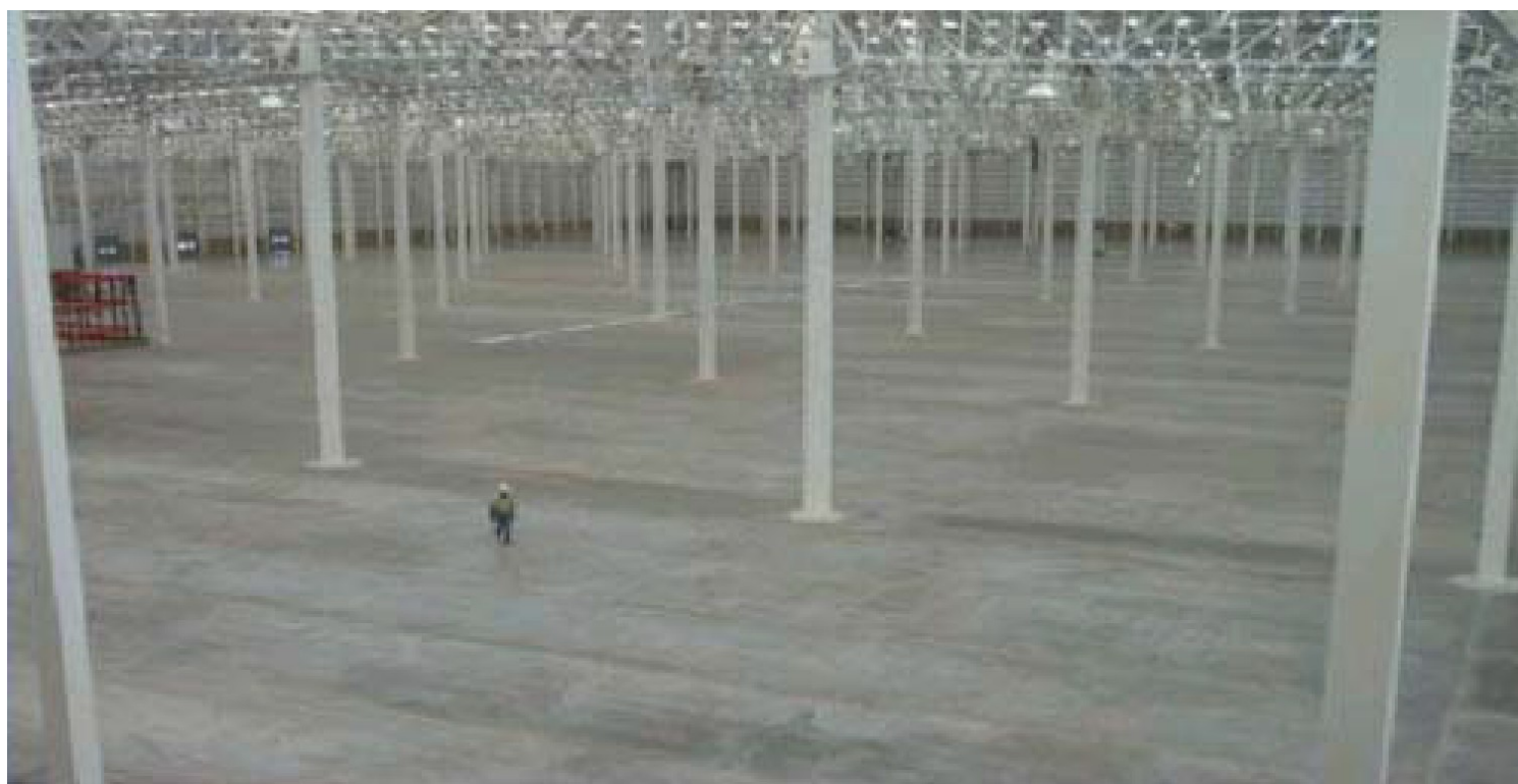
Stabilimento Nestlè in Cile cosiddetto “La casa de piedra”: 400.000 m 2 di pavimento posteso.
