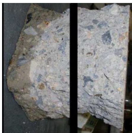
Calcestruzzo senza Aeternum | Calcestruzzo con Aeternum
