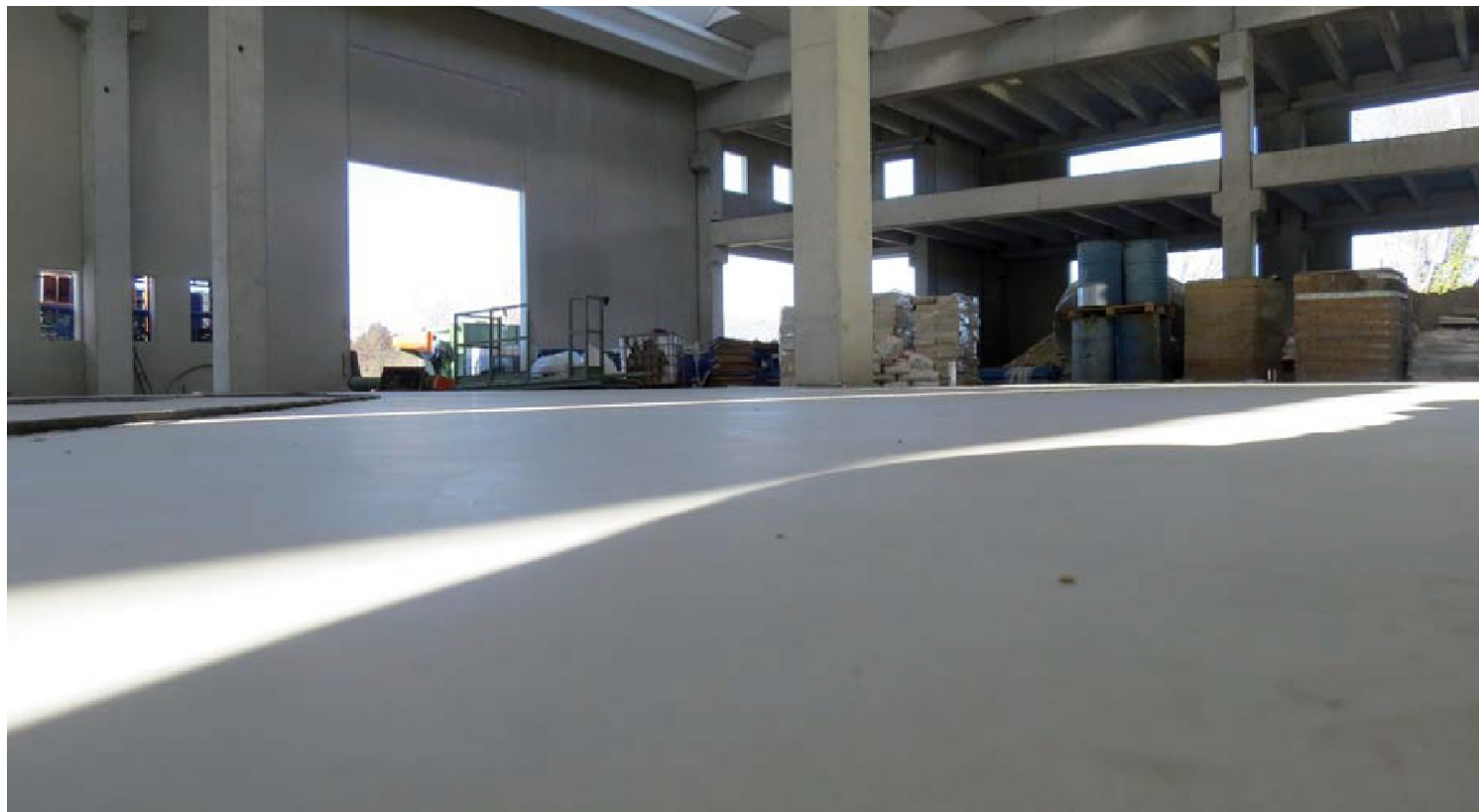
Pavimento posteso in esecuzione nella nuova ala del complesso di Renate, sede I.I.C.
