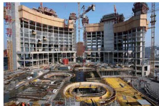
In accordo con Impresa e D.L. questo calcestruzzo viene verificato a 56 giorni invece che a 28, in modo da permettere l'incremento graduale delle resistenze. Per quanto riguarda i calcestruzzi ad altissima resistenza, con particolari caratteristiche di fluidità per permettere il pompaggio fino a 160 m di quota nell'area Garibaldi è
