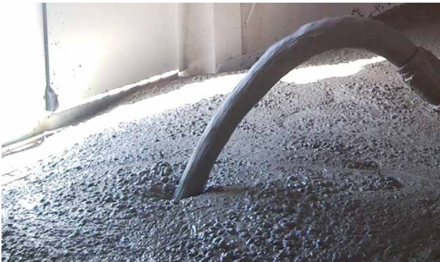
L'Aeternum CAL impiegato per i lavori di rifacimento delle sponde del Canale Villoresi, a Monza.
