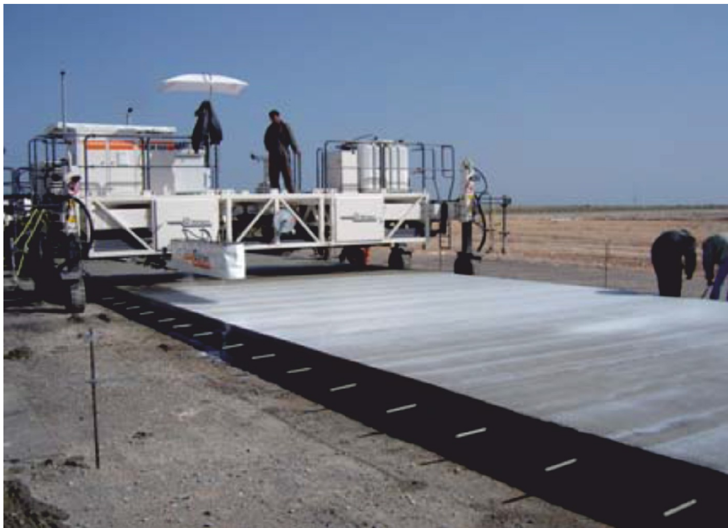
Stesura del calcestruzzo con tecnologia slip form orizzontale
