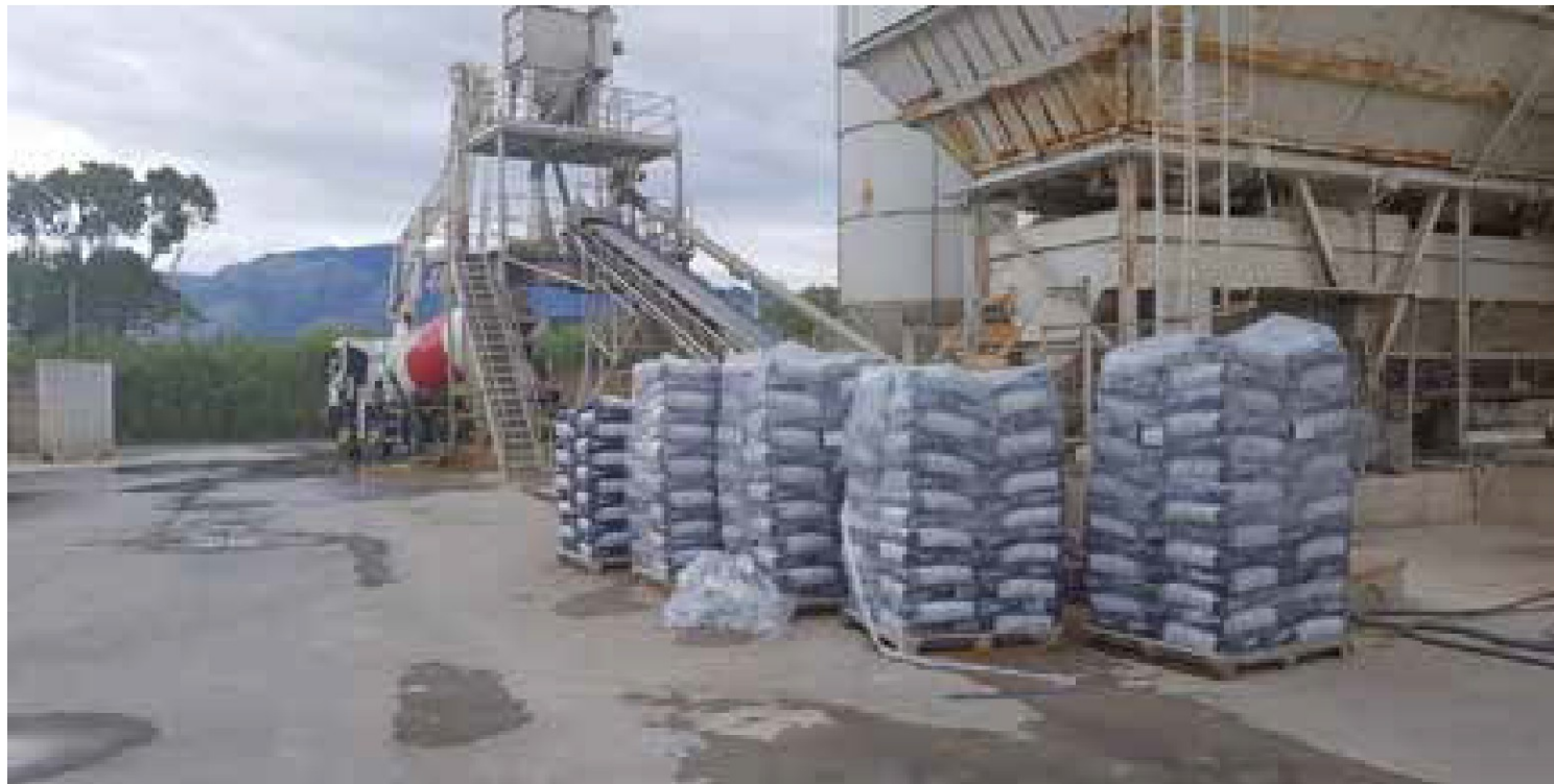
Il compound Tekna Chem nell'impianto di premiscelamento
