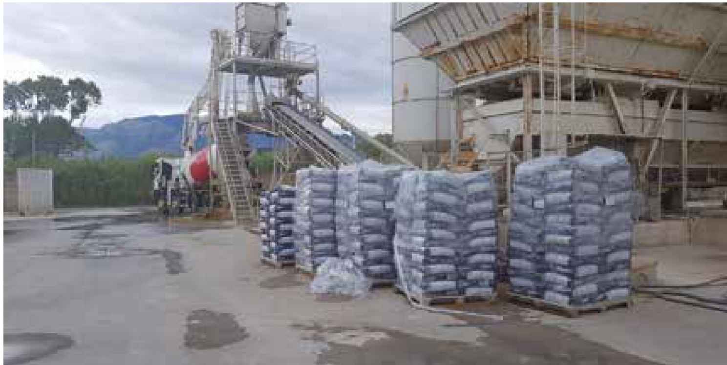
Il compound Tekna Chem nell'impianto di premiscelamento
