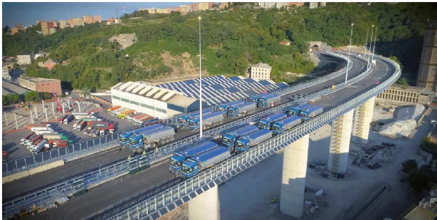
Un momento del collaudo del Ponte di Genova San Giorgio, era l'estate 2020
