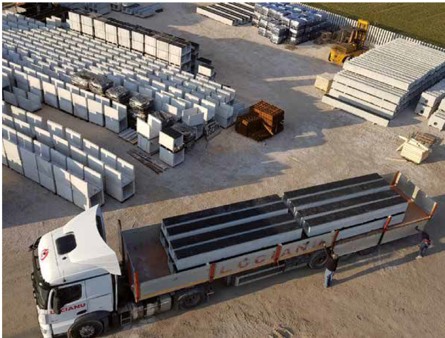
Una soluzione su misura per il grande cantiere dell'aeroporto di Olbia
