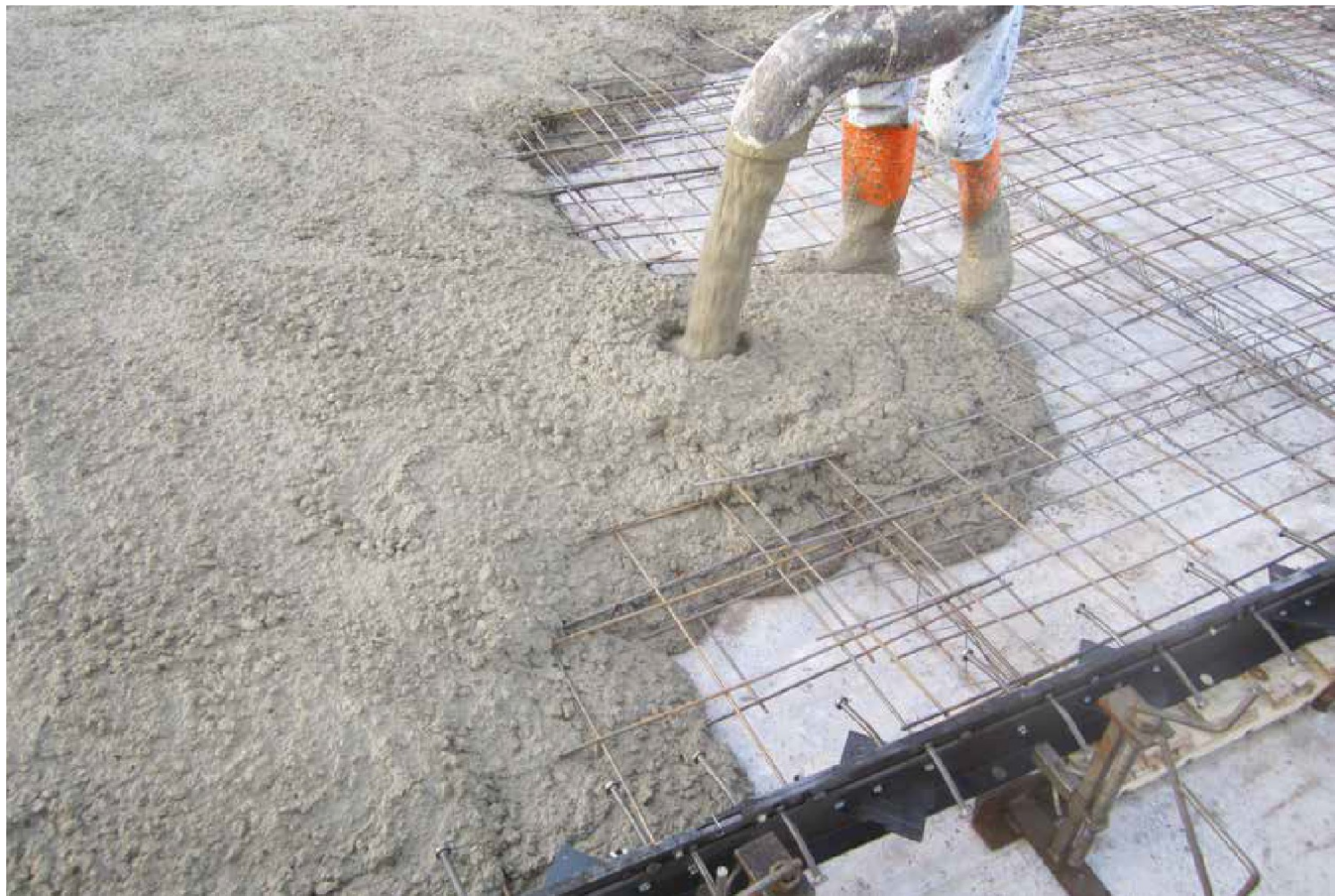
Calcestruzzo gettato in opera
