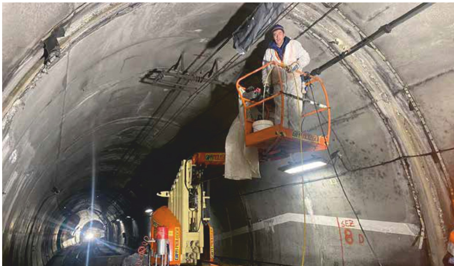
Intervento in galleria con i prodotti Tekna Chem.
