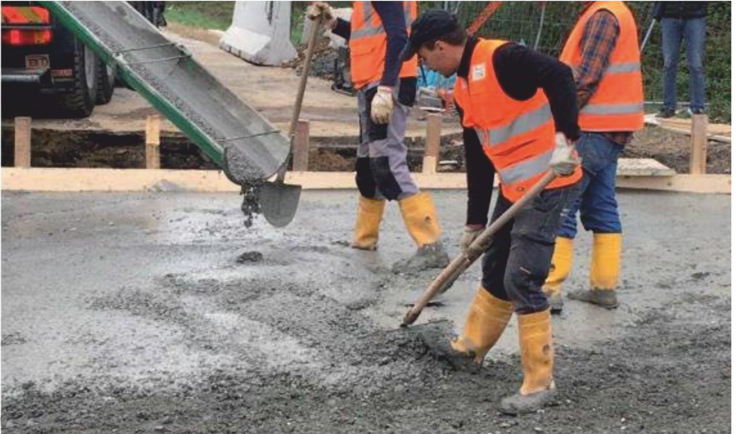
Getto del calcestruzzo speciale progettato e prodotto secondo lo standard AeternumCal
