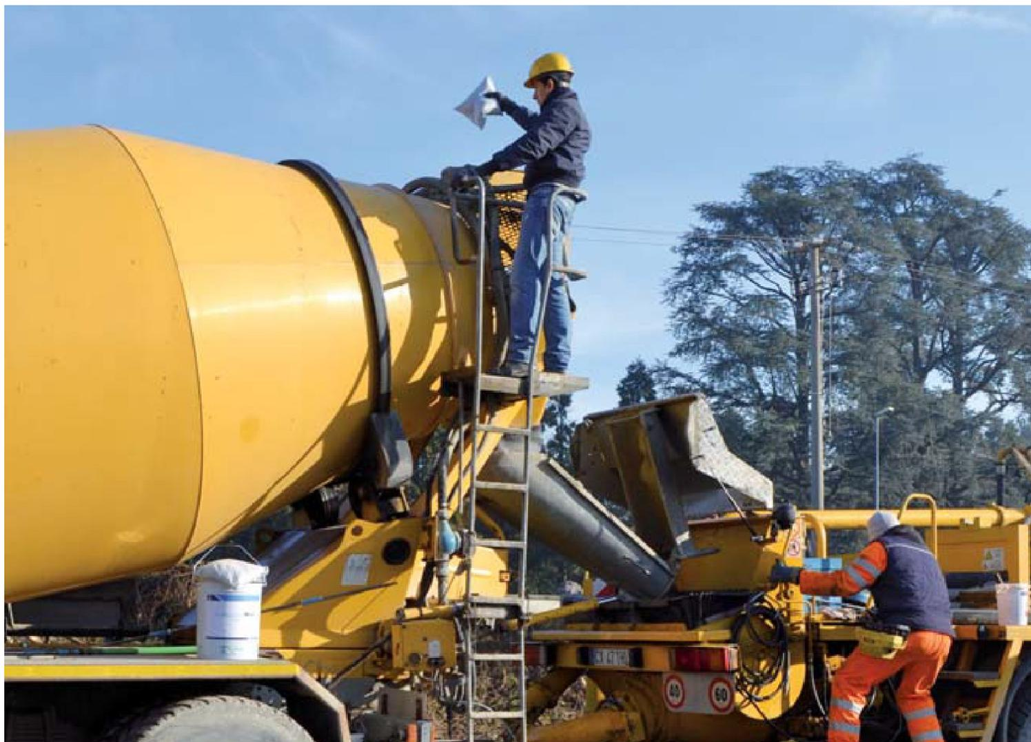
Se i tempi di scarico si prolungano e il calcestruzzo inizia a perdere le sue caratteristiche progettuali di consistenza, **ACQUANO! è l'unica soluzione specifica per non utilizzare acqua in cantiere.** ACQUANO! è un compound in polvere di ultima generazione e tecnologia. La sua caratteristica principale risiede nel ridonare fluidità al calcestruzzo senza alterare il rapporto a/c.
