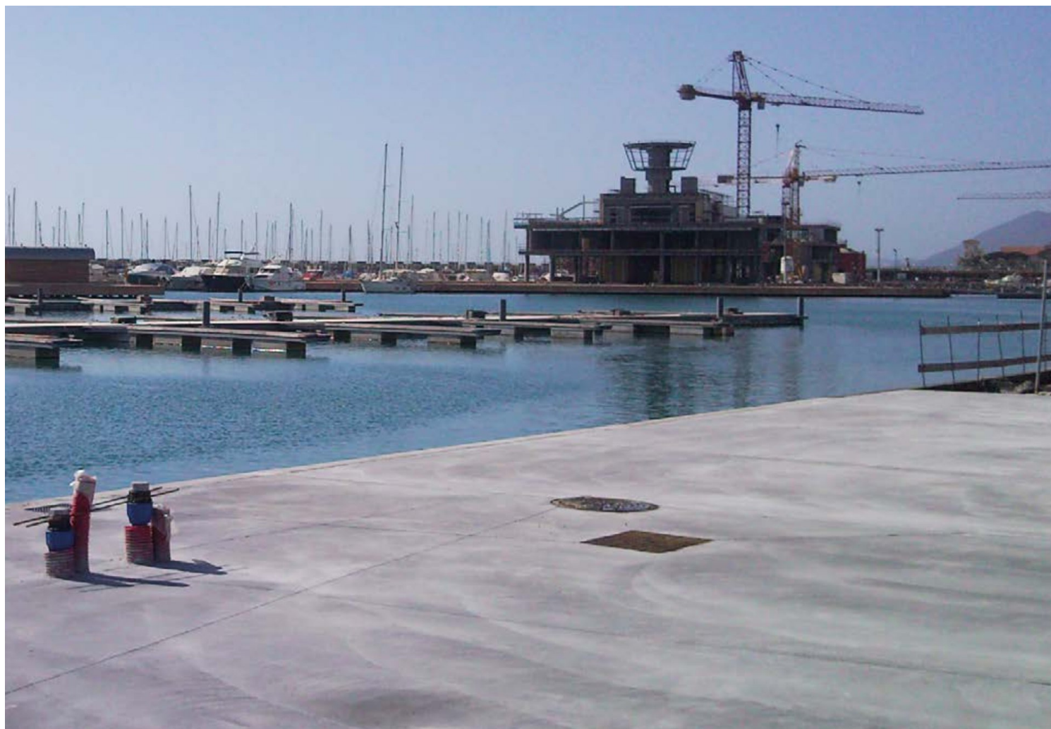
Pavimentazione della banchina al porto di Loano
