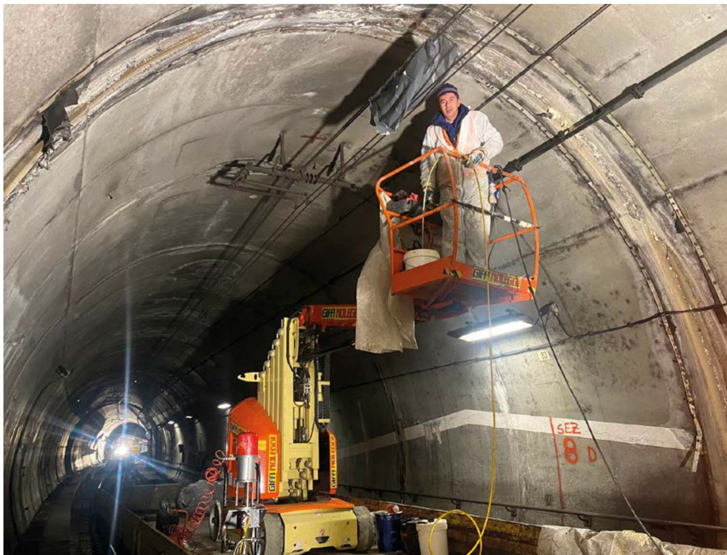
Lavori di ripristino metropolitana milanese
